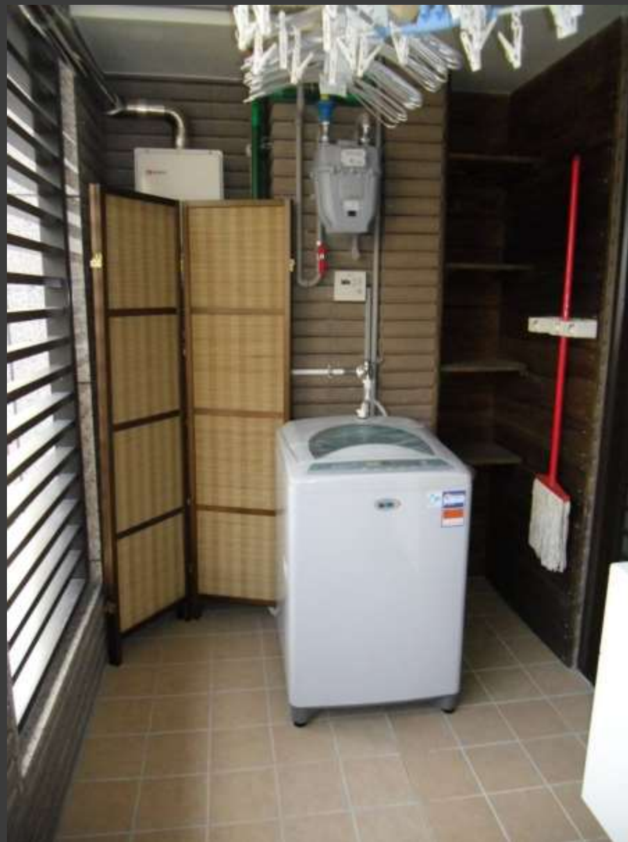
整修後照片 After
